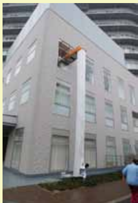
3 階から、垂直降下型の脱出路を用いた脱出訓練も
